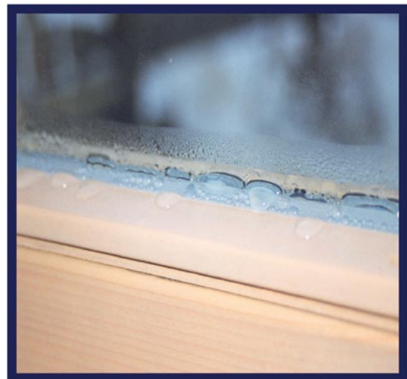
Bild 2 Tauwasserbildung am Glasrand
